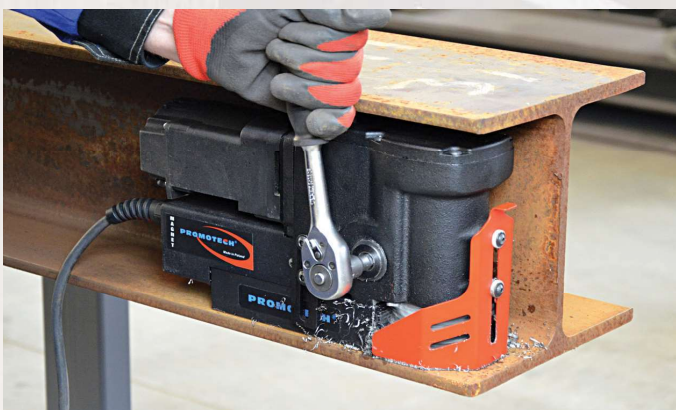
Wiercenie w trudno dostępnych miejscach
